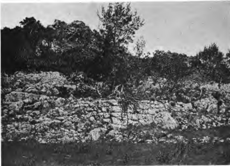
Mauer im Patio der alten Stadt
